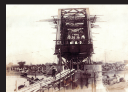
橋脚に設置中のトラス部材
