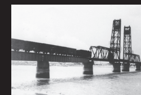
貨物列車が通過する筑後川昇開橋
