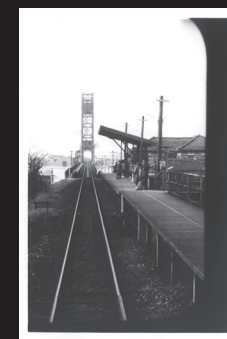
筑後若津駅に接近する列車車窓から見た筑後川昇開橋
