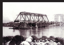
台船により運搬中のトラス部材
