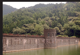
6. 現在の河内貯水池堰堤を上流側から望む 中央は半円形の取水塔
