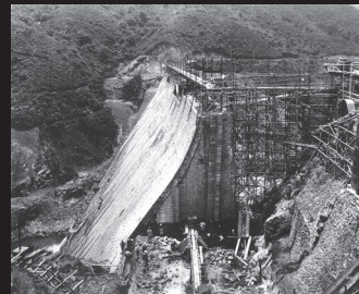
3. 建設中の河内貯水池堰堤 構造は両面石張重力式含石コンクリートダム
