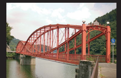
12. 現在の南河内橋
