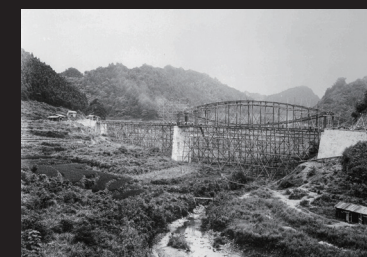
11. 建設中のレンティキュラートラス
