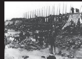
8.潮止め工事中の三池港
