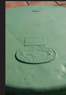
12.閘門部材に付けられた英国製を示す銘盤
