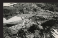
9.竣工時の奥津調整池
