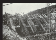
3.建設中の恩原ダム
