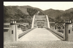
5.竣工時の方谷橋(正面)
