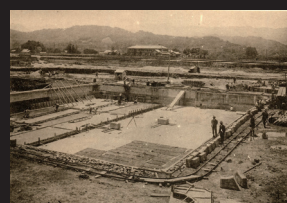
3. 建設中の濾過池
