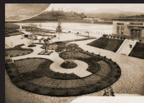
1. 竣工当時の浄水場園地前庭
