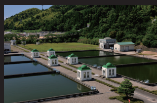
4. 現在の濾過池と浄水井上屋
