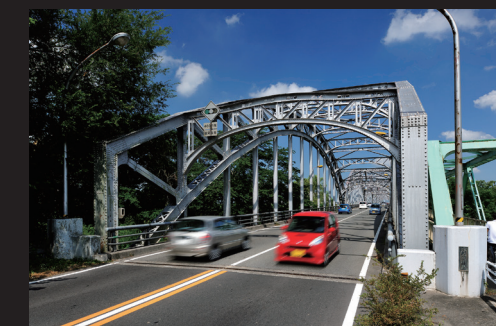
5.現在の木曾川橋 左岸側より
