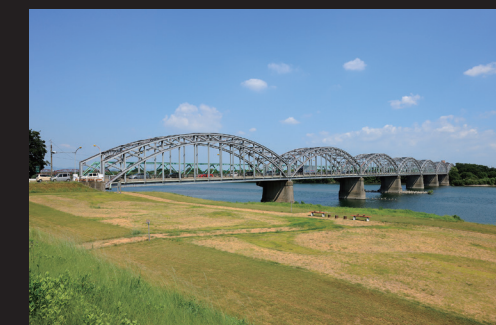
6.右岸側より 現在も県道として供用されている
