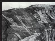
8.牛伏川源流の砂防工事 斜面対策の積苗工(泥沢)
