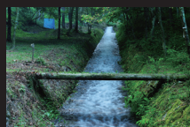
9.階段工より上流に 施工された張石水路
