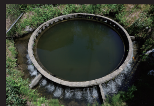
1.均等に分配する円筒分水槽
