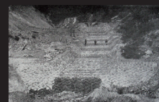
6.建設中の階段工
