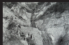
7.牛伏川源流の砂防工事 多段の石堰堤(地獄谷)
