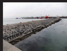
船川港第二船入場防波堤 (南東側)
