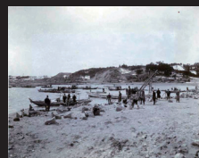
埋立護岸用 間知石積み出しヤード
