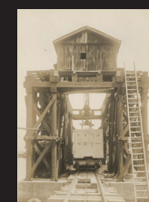
木造軌道起重機
