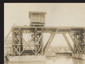
木造軌道起重機
