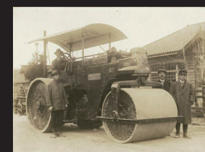
路面転圧用マカダムローラー (英国製)
