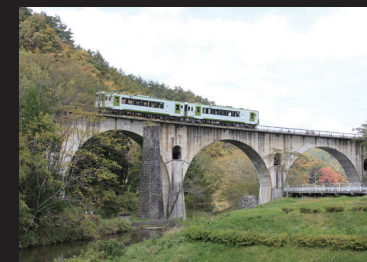
5.宮守川橋梁を渡るJR気動車 手前には旧岩手輕便鉄道宮守川橋梁の石造橋脚が現存する。
