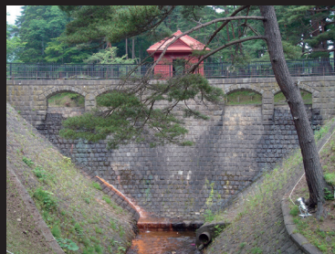
4.堰堤下流側正面
