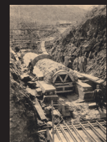
10.配水管路工事状況
