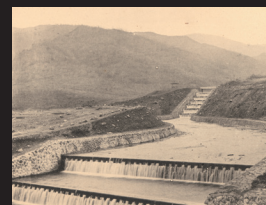
13.建設当時の段差工
