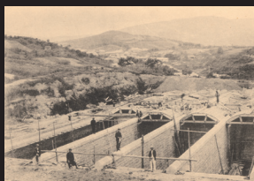
11.配水地工事状況
