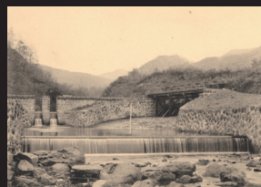
12.建設当時の堰堤
